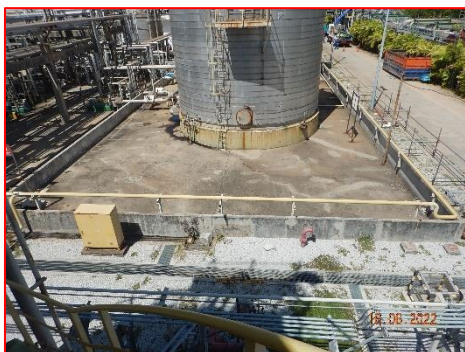
ภาพที่ 2.2-52 กำแพงกั้นบริเวณถังสำรอง สารเคมี
