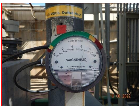
ภาพที่ 2.2-17 Pressure Gauge ป่อ Surge I
