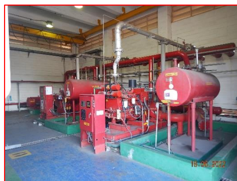
ภาพที่ 2.2-44 เครื่องสูบน้ำดับเพลิง
