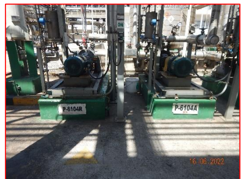
ภาพที่ 2.2-9 Double Mechanical Seal Pump
