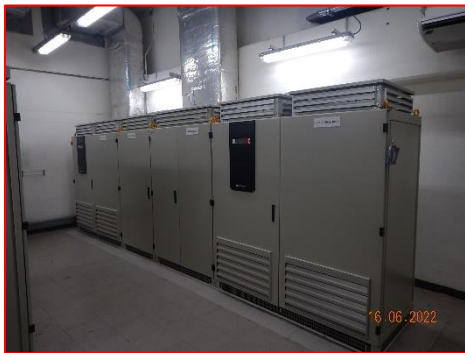
ภาพที่ 2.2-50 ระบบไฟสำรองแบบยูพีเอส (UPS)
