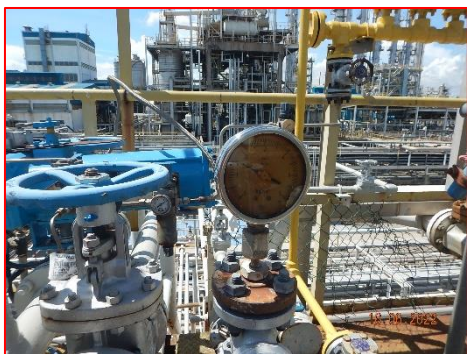
ภาพที่ 2.2-54 Pressure Indicator บริเวณ ถังเก็บกัก
