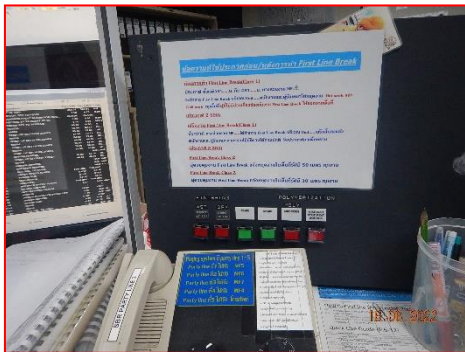
ภาพที่ 2.2-6 Emergency Shutdown Push Button Switch ที่ห้อง Control Room
