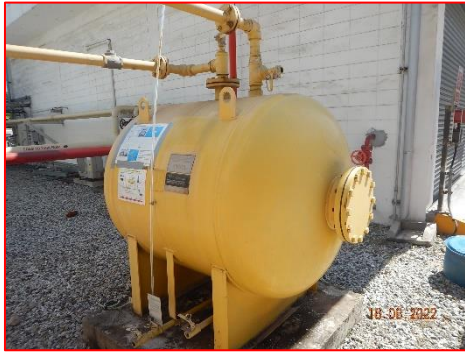
ภาพที่ 2.2-45 Bladder Foam Tank
