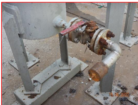
ภาพที่ 2.2-10 Line Drain ที่มีฝาปิด
