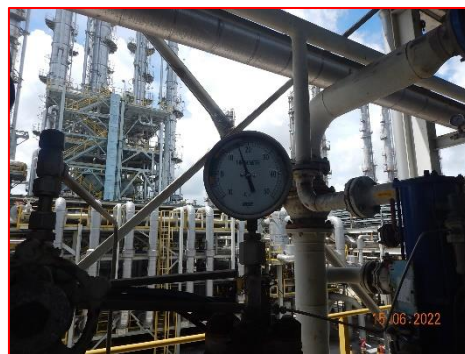
ภาพที่ 2.2-55 Temperature Indicator บริเวณ ถังกักเก็บ
