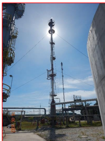
ภาพที่ 2.2-4 หอเผาที่จ้งระดับเหนือพื้นดิน (Elevated Flare)
