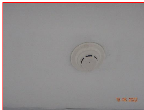
ภาพที่ 2.2-40 Smoke Detector บริเวณอาคารต่างๆ
