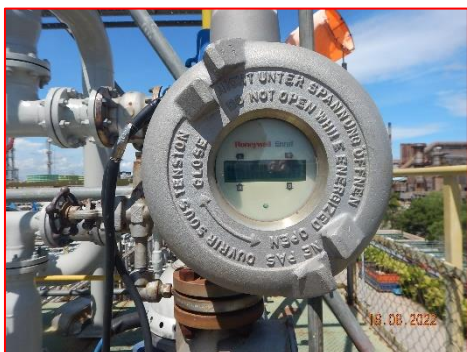
ภาพที่ 2.2-56 Level Indicator บริเวณ ถังกักเก็บ
