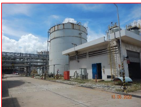
ภาพที่ 2.2-43 ถังเก็บสำรองน้ำดับเพลิง
