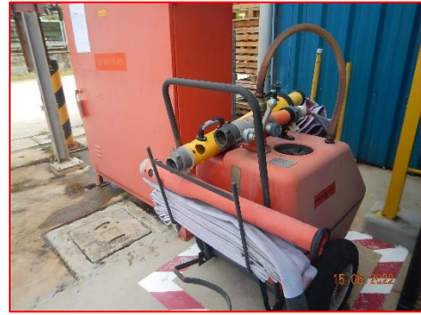
ภาพที่ 2.2-46 Mobile Foam Tank
