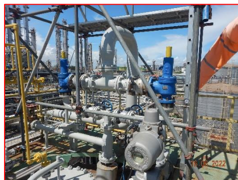
ภาพที่ 2.2-57 Pressure Relief Valve บริเวณถังกักเก็บ
