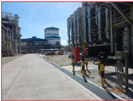
ภาพที่ 2.2-47 การติดตั้ง Hydrant ทุกระยะ 50 เมตร
