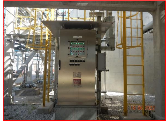
ภาพที่ 2.2-5 หอเผาที่ระดับพื้นดินแบบมิดชิด (Enclosed Ground Flare)
