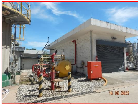
ภาพที่ 2.2-48 หัวจ่ายน้ำและโฟมดับเพลิง
