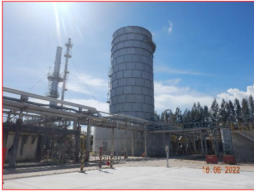
ภาพที่ 2.2-5 หอเผาที่ระดับพื้นดินแบบมิดชิด (Enclosed Ground Flare)
